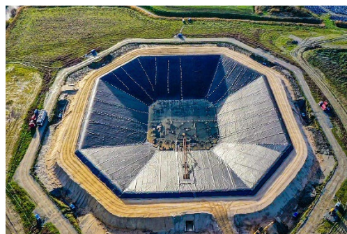
Ein Bild aus 2022 vom Bau des Erdspeichers in Meldorf. Foto: WIMeg
